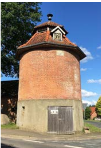
Abb. 26: Wasserturm in Barum, Kr. Uelzen. (Foto: Irmingard Kruse)
