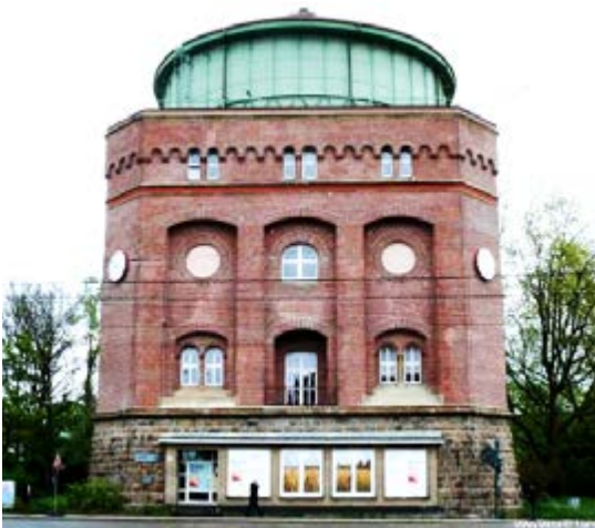
Abb. 25: Wasserturm in Essen. (Foto: G. Bötel)
