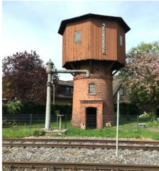
Abb. 13: Bahnwasserturm Wadersleben – durch eine unterirdische Zuleitung gelangte das Wasser über einen Wasserkran in die Lok. (Foto: Irmingard Kruse)
