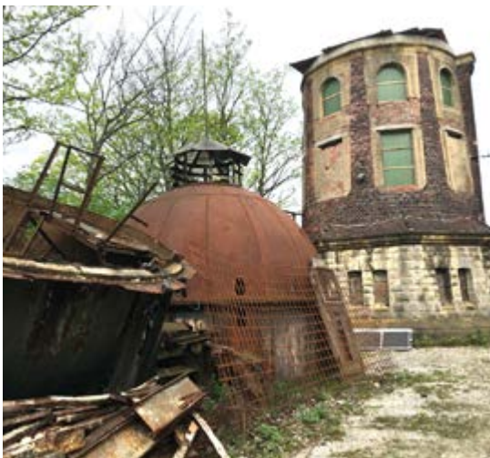
Abb. 9: Bahnwasserturm Bielefeld mit zerlegtem Kessel. (Foto: Irmingard Kruse)
