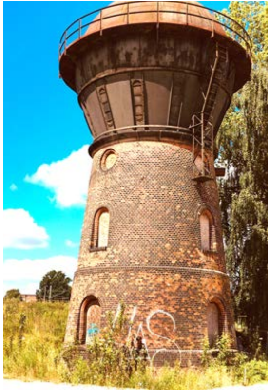
Abb. 10: Bahnwasserturm Lübeck auf einem Fundament von 8 m Tiefe. (Foto: Irmingard Kruse)
