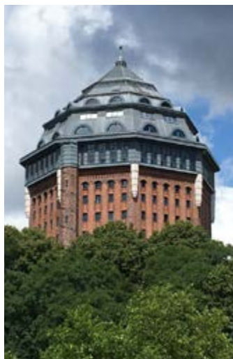
Abb. 28: Wasserturm im Schanzenviertel Hamburg. (Foto: Irmingard Kruse)
