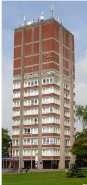
Abb. 42: Wohnwasserturm in Nordenham. (Foto: G. Bötzel)
