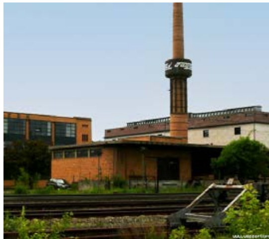
Abb. 22: Schornsteinwasserturmbehälter mit Manschette in Alfeld. (Foto: G. Bötel)
