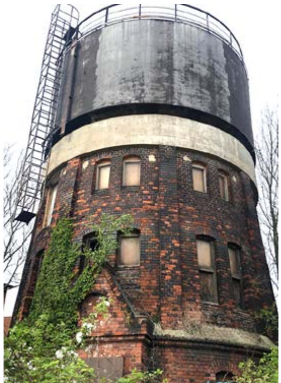
Abb. 11: Bahnwasserturm mit zylindrischem Aufbau in Stendal. (Foto: Dorothea Kruse)
