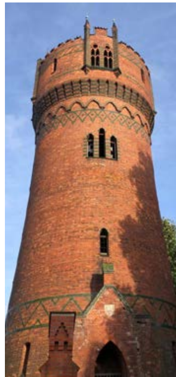
Abb. 35: Wasserturm in Wismar. (Foto: Helge Voigts)
