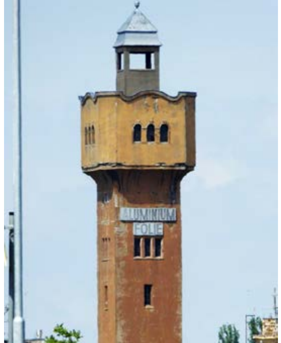
Abb. 17: Schornsteinwasserturmbehälter in Merseburg. (Foto: G. Bötzel)
