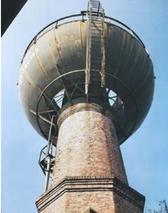
Abb. 15: Schornsteinwasserturmbehälter Wedel. (Foto: M. Krüger, Eisenbahnmuseum Bochum)
