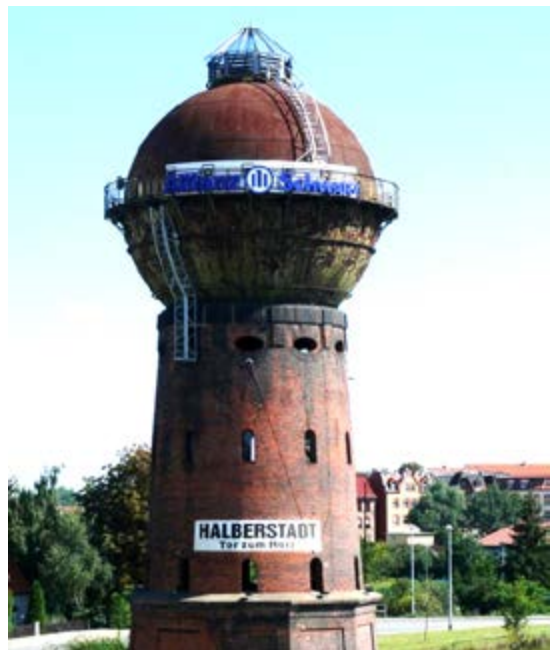
Abb. 18: Bahnwasserturmbehälter in Halberstadt. (Foto: G. Bötzel)
