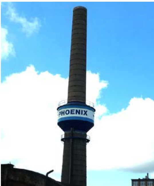
Abb. 16: Schornsteinwasserturmbehälter mit Schornsteinmanschette in Hamburg-Harburg. (Foto: Irmingard Kruse)
