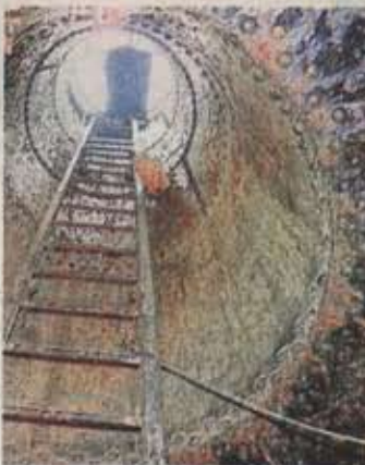
Eine schmale Leiter führt zum Wasserspeicher.
