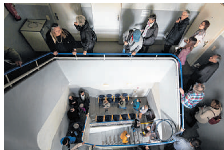
So komfortabel wie hier an der Steeler Straße ist nicht jeder Wasserturm zu erklimmen. Oft gibt es nur behelfsmäßige Stiege für das Wartungspersonal.
