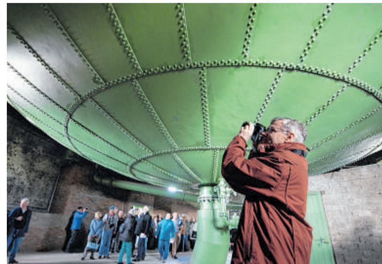
Der riesige Tank an der Steeler Straße wurde aus Schmiedeeisen gefertigt und fasst 2000 Kubikmeter Wasser. Das ist schon mal ein Foto wert.
